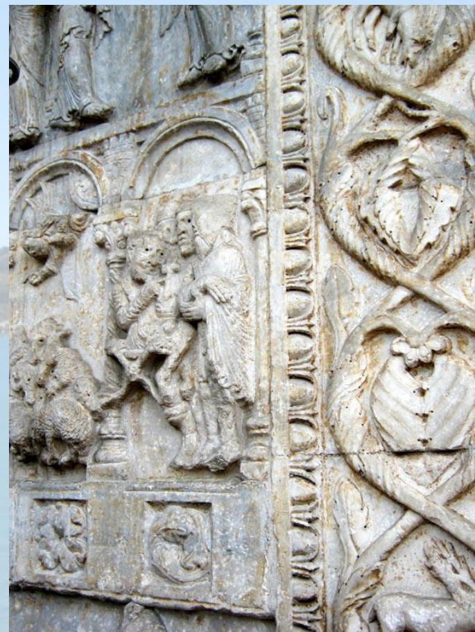
Reliefní výzdoba fasády kolem brány (kvůli rekonstrukci většinou zakrytá)
